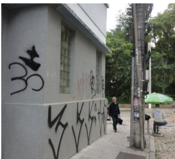
Fig.: 70: Prédio dos Correios em reformas.
